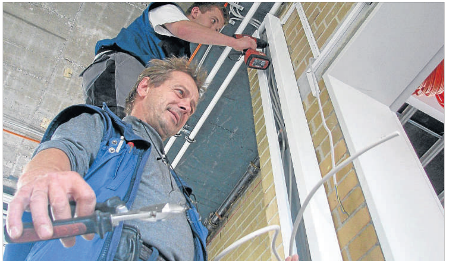
Neue Strippen: Timo Wetzels (oben) und Viktor Schmidt von der Firma Freybank erneuern in den Klassenräumen des Gebäudes acht der Wolfhager Grundschule im Moment die Elektroinstallation.
