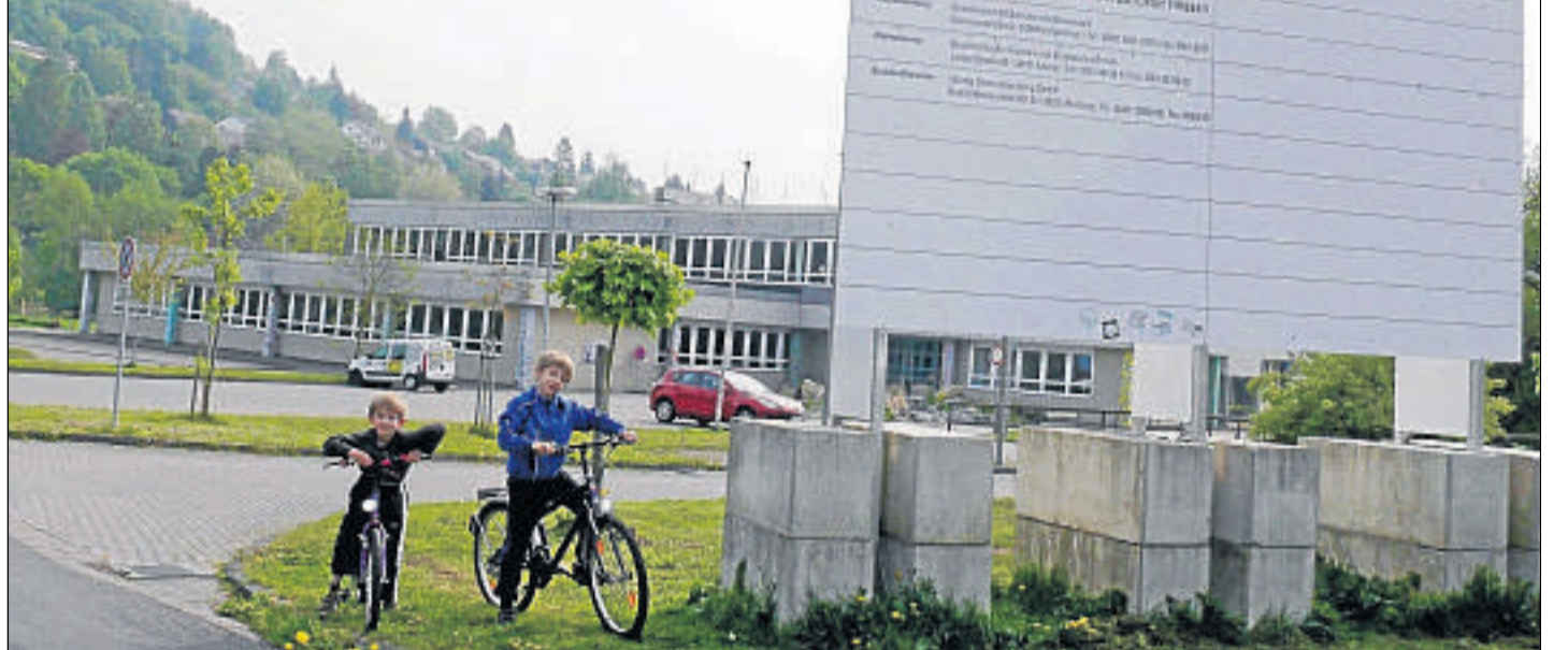
Bald fertig: Die Arbeiten an der Zierenberger Elisabeth-Selbert-Schule sind nahezu abgeschlossen. Derzeit wird nach Informationen des Kreises noch im Innenbereich gearbeitet.
